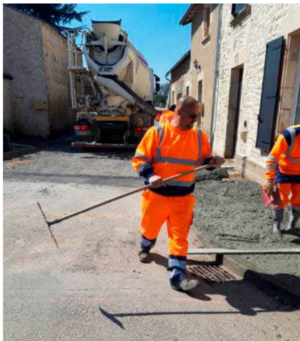
Travaux de voiries rue des Sablières
